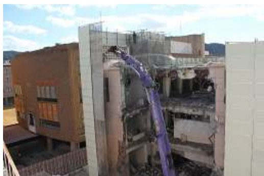
大島会館解体
