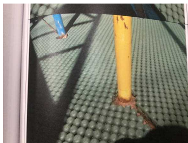
↑支柱地際及び土台の錆び
