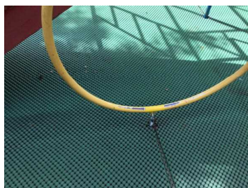
↑チェーン連結部のほか、支柱地際及び土台錆びの補修もあわせて実施
