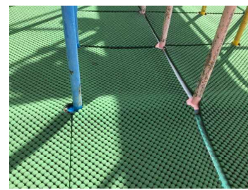
↑経年劣化による錆び付きが各所にみられた
