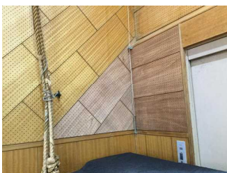
← 北西隅の板張り・塗装
