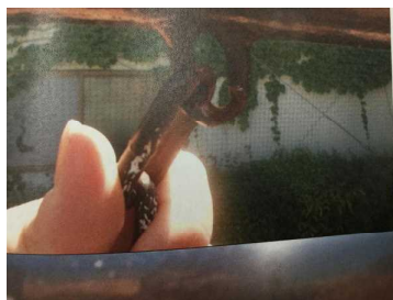
↑チェーン連結部の錆び
