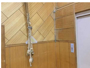
↑北西隅の状態
