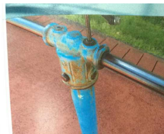
↑上部及びソケットのがたつき・支柱地際腐食
