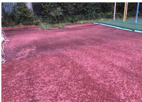
↑ (左) グラウンド東側面へこみ (右) 西昇降口コンクリート面のひび ゴム面の反り
