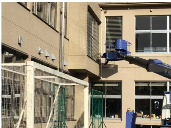
↑ (左) 高所作業車に乗り込み、鉄球が付いた金棒を壁面に転がしながら、タイルの浮き音を聞き分けていた
